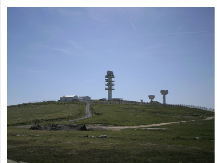
La station hertzienne de Pierre-sur-Haute. On distingue les deux tours militaires, la tour relais de TDF au centre, les bâtiments de vie, ainsi qu'une hélisation.
