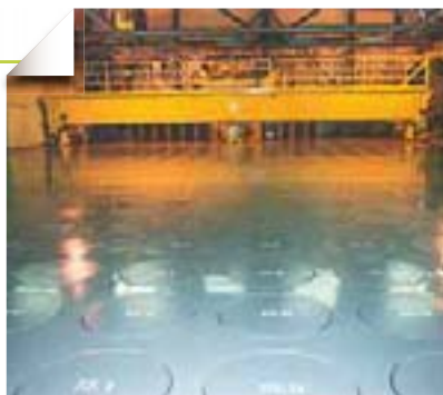
Entreposage de déchets HA
