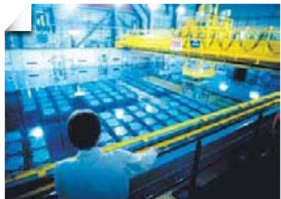
Entreposage de combustibles usés en piscine de refroidissement
