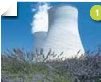
Centrale de Cruas
