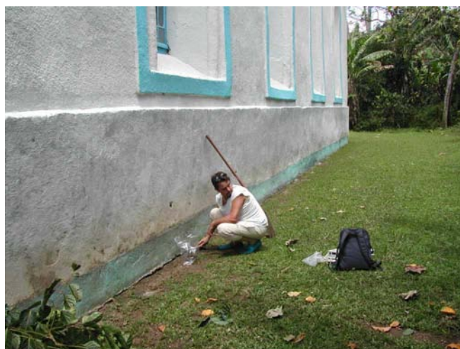
T2 / N°259 : prélèvement de sol de gouttage du toit de l'église Saint Gabriel à Taravai. CRIIRAD, le 6 octobre 2005.
