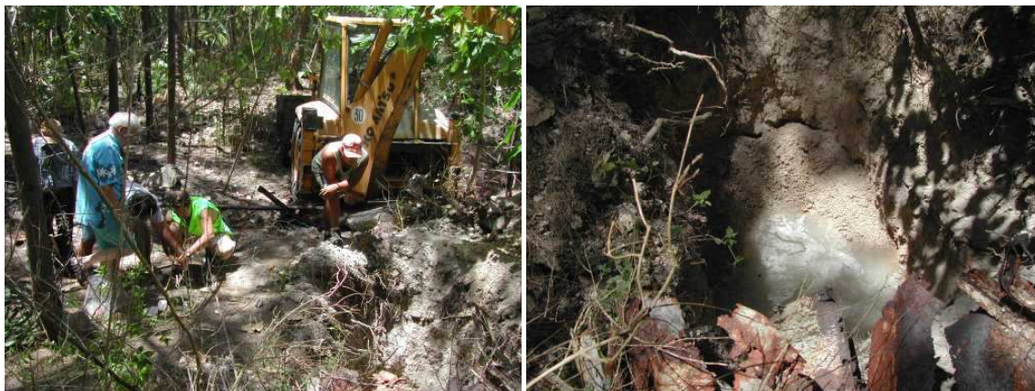
T6 / N°100 et 101 : réalisation d'un sondage au tractopelle au milieu des gravats de l'ancien bâtiment radiochimie, secteur CEA au Sud du village d'Otepa à Hao, vue du fond de fouille (eau E4) . CRIIRAD, le 12 octobre 2005.
