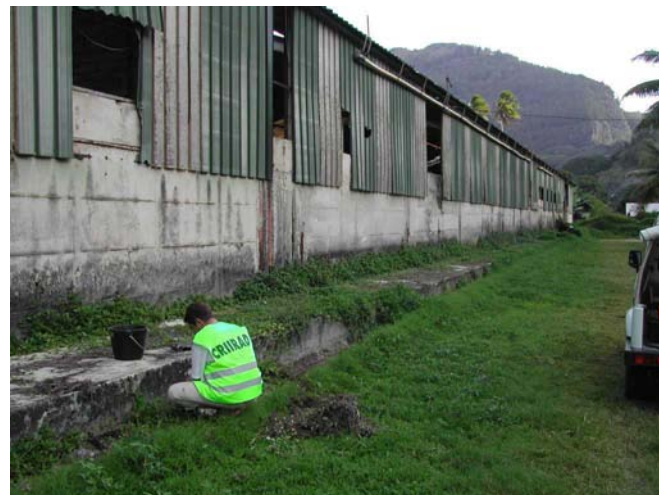
T4 / N°13 : échantillonnage de ciment poreux de l'ancien caniveau de récupération des eaux de lavage de la façade ouest du toit du hangar destiné à protéger la population à Rikitea (Mangareva). CRIIRAD, le 8 octobre 2005.
