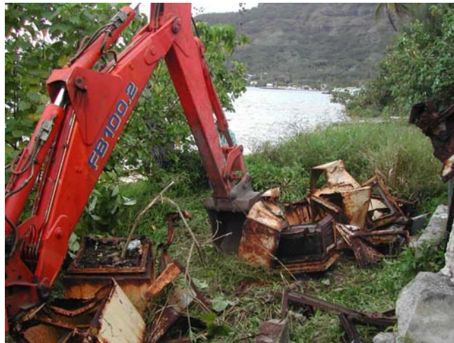
T3 / N°67 : extraction au tractopelle des caissons à charbon actif destinés à épurer l'air des iodes radioactifs avant insufflation dans le hangar destiné à la protection des populations lors des retombées radioactives à Rikitea (Mangareva). CRIIRAD, le 7 octobre 2005.
