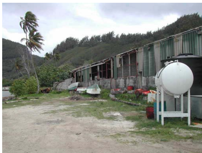
T3 / N°87 : Localisation du bâtiment contenant les anciens dispositifs de filtration de l'air sur la façade est du hangar destiné à la protection des populations lors des retombées radioactives à Rikitea (Mangareva). CRIIRAD, le 7 octobre 2005.
