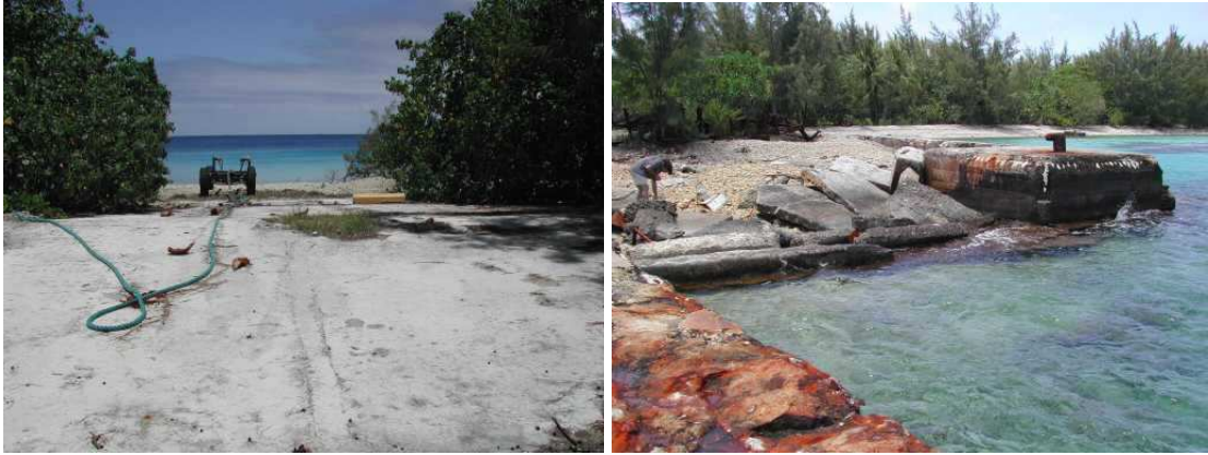
T6 / N°10 et 16 : ancienne pente de halage des bateaux contaminés et abords du quai CEA-SMSR
