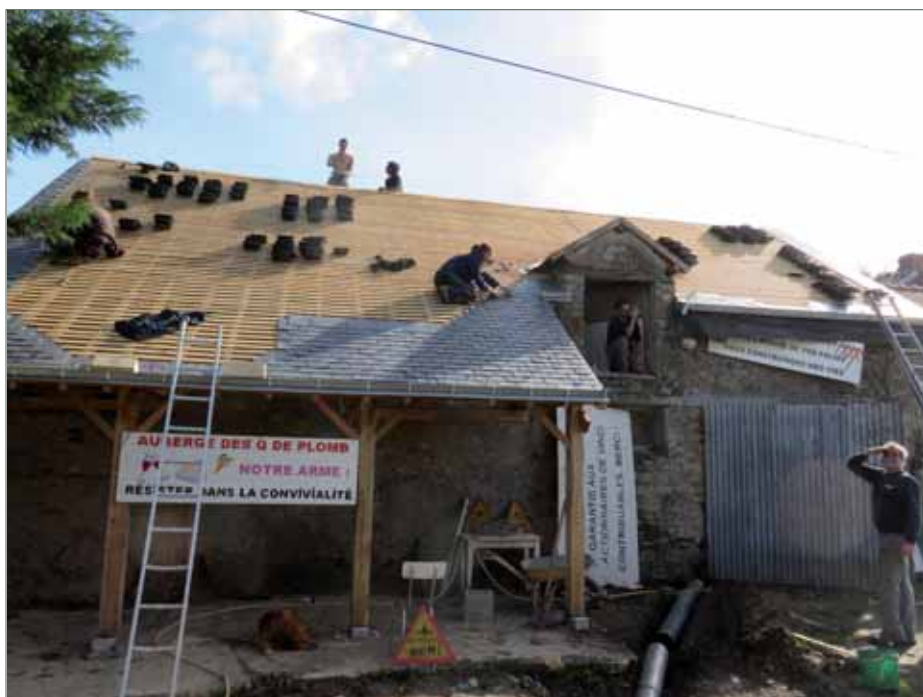
L'Auberge des Q de plombs: cet été, un grand chantier public de rénovation de la grange du Liminbout a permis de rénover un bâtiment (charpente, couverture en ardoise, maçonnerie) pour y installer une conserverie, une auberge et une salle de banquet.
